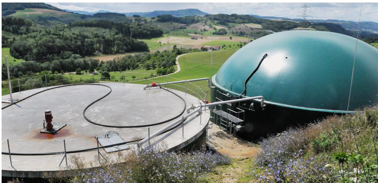
Installation de co-digestion agricole pour produire de l'énergie à partir d'engrais de ferme et de co-substrats (moins de 20%)
