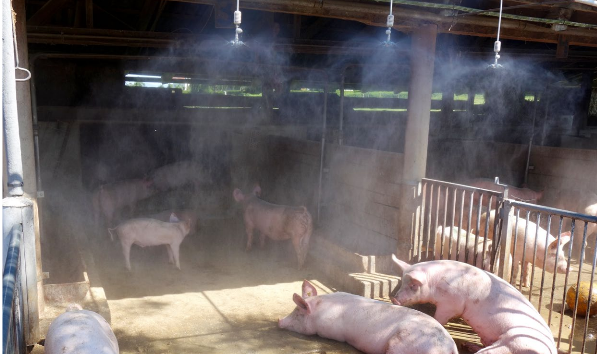
Les buses de nébulisation constituent une méthode efficace et économe en eau pour refroidir l'aire d'exercice et réduire le stress thermique chez les porcs.
