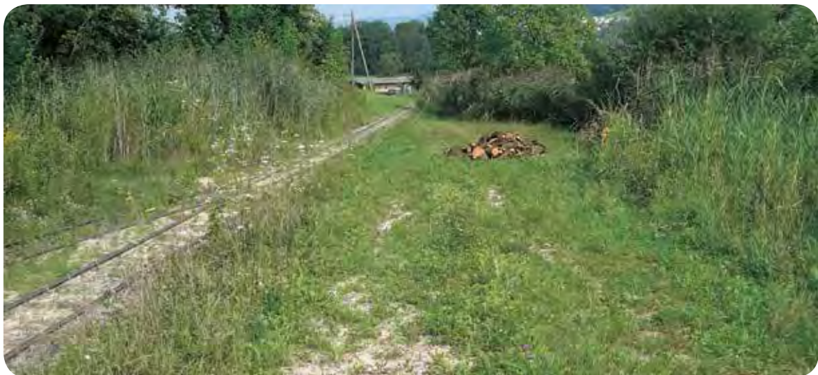
Dieser Randbereich einer stillgelegten Gleisanlage gehört zur Betriebsfläche, nicht aber zur LN. Die Fläche kann trotzdem unter der Rubrik „Ruderalfläche“ als BFF gemeldet werden.
