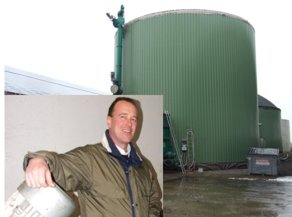
Figur 17: Hubert Miller, økologisk planteavlser i Schmiechen/Tyskland siden 1980'erne, har drevet et 350 kW biogasanlæg med ekstra høj reaktortank og vertikal omrøring i 6 år. Han bruger en biomasseblanding med op til 98 % kløvergræs fra 40 økologiske bedrifter. Foto: F. Gerlach, MEP.
