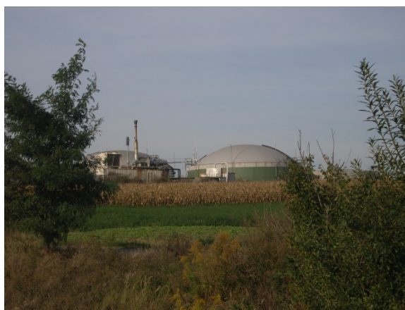
Figur 9: Den største malkekvægsbesætning i Spanien driver et af de kun 32 landbrugs biogasanlæg i landet, med gylle fra 2.500 køer. Afgasset gylle tørres og sælges som gødning til økologiske landbrug. Foto: STUDIA.
