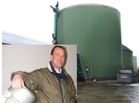
Rys. 17: Hubert Miller, rolnik ekologiczny ze Schmiechen w Niemczech, od sześciu lat prowadzi 350 kW biogazownię z wyjątkowo wysokim fermentorem i pionowym systemem mieszania. Stosuje mieszankę substratów przy maks. 98% udziale koniczyny z około 40 gospodarstw ekologicznych. Zdjęcie: F. Gerlach, MEP.
