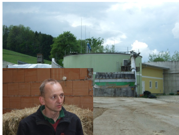
Figure n°8 : Schwanenstadt (Haute-Autriche). Gerhard Übleis gère une installation de biogaz utilisant un mélange de matières premières conventionnelles et biologiques. La chaleur est utilisée pour sécher les copeaux de bois afin de produire de l'énergie. Photo : F. Gerlach, FiBL.
