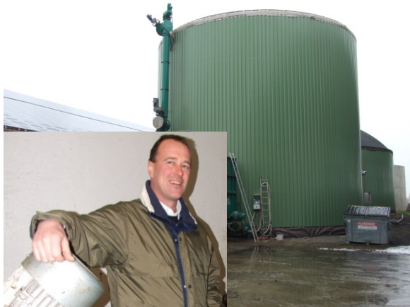
Figure n°17 : Hubert Miller, agriculteur bio à Schmiechen (Allemagne) depuis les années 80, exploite depuis six ans une installation de biogaz de 350 kWe dotée d'un fermenteur très haut et d'un dispositif d'agitation vertical. Il utilise un mélange de substrat comprenant jusqu'à 98 % de trèfle provenant de près de 40 fermes bio. Photo : F. Gerlach, MEP.
