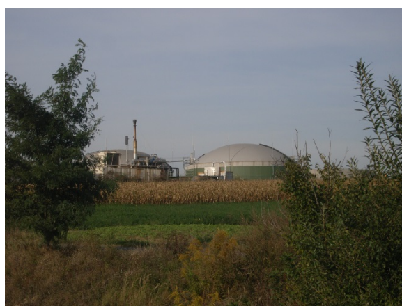
Figure n°9 : La plus grande exploitation laitière d'Espagne accueille l'une des 32 installations de biogaz agricole du pays, fonctionnant à partir du lisier produit par 2 500 vaches. Le digestat est séché et vendu comme engrais pour l'agriculture biologique. Photo : STUDIA.
