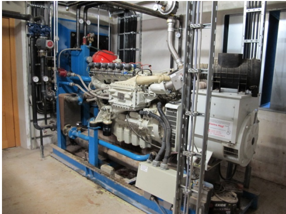
Figure n°29 : Cogénération : production de chaleur et d'électricité à partir du biogaz. Photo : V. Jaensch, RENAC.
