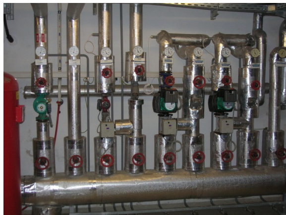
Figure n°23 : Distribution de la chaleur dans une installation de biogaz. Les installations professionnelles peuvent utiliser une grande partie de la chaleur produite. Photo : MEP.
