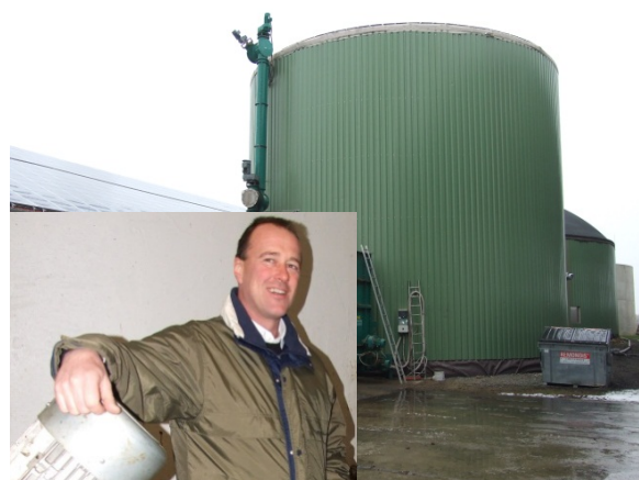
Figura 17: Hubert Miller, agricultor de cultivos orgánicos en Schmiechen / Alemania desde la década de 1980, ha estado operando una planta de biogás de 350 kW con un alto fermentador adicional y agitación vertical durante seis años. Utiliza una mezcla de sustrato con hasta un 98% de pastos de alrededor de 40 granjas orgánicas. Foto: F. Gerlach, MEP.
