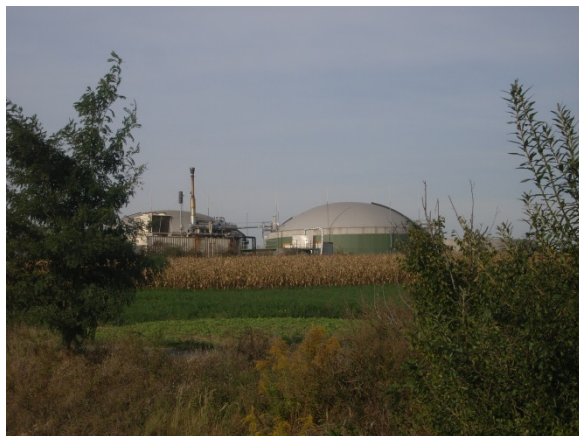
Figura 9: La granja lechera más grande del país en España opera una de las más de 30 plantas de biogás agrícola existentes, con estiércol procedente de 2500 vacas. El digestato es secado y vendido como fertilizante para la agricultura ecológica. Photo: STUDIA.
