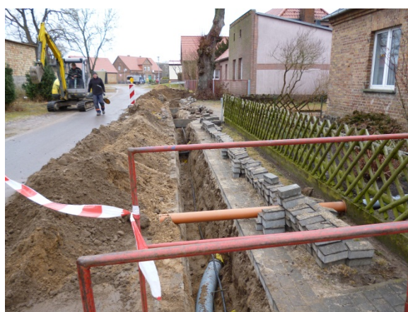
Figura 14: "District heating" con energía de biogas mejora la eficiencia y puede ser un bonus para las infraestructuras rurales. Foto: N. Hölzer, MEP.
