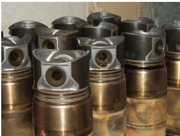
Abbildung 28: Regelmäßige BHKW-Wartung ist unverzichtbar für einen zuverlässigen Betrieb. Im Bild: Zylinderköpfe eines Biogasmotors. Foto: F. Gerlach, MEP.
