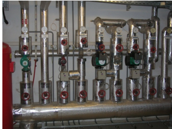
Abbildung 23: Wärmeverteilung in einer Biogasanlage. Professionelle Konzepte können einen Großteil der erzeugten Wärme nutzen. Foto: MEP.
