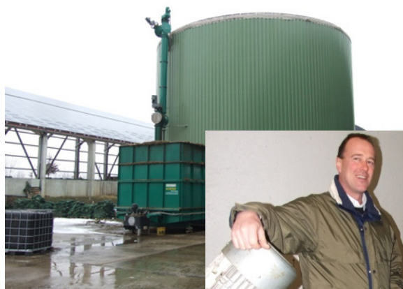
Abbildung 17: Hubert Miller, seit den 1980ern ökologisch wirtschaftender Ackerbauer in Schmiechen/Deutschland, betreibt seit 1996 eine 350 kW Biogasanlage mit hohem Fermenter und vertikalem Rührwerk. Er nutzt in seinem Substratmix bis zu 98 % Klee gras von zahlreichen ökologisch wirtschaftenden Kollegen. Foto: F. Gerlach, MEP.
