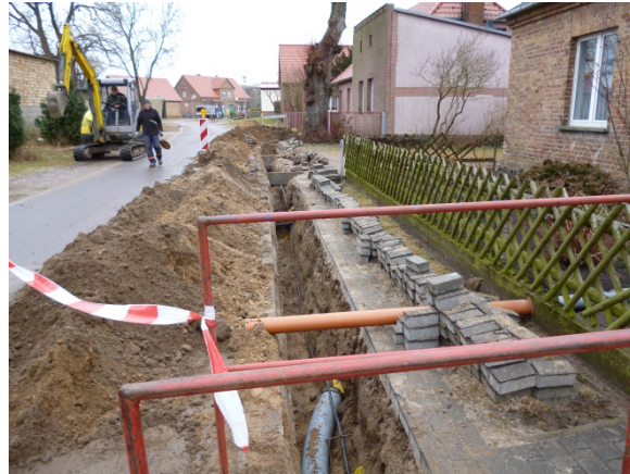
Abbildung 14: Fernwärme mit Biogasenergie verbessert die Effizienz und kann ein Bonus für die ländliche Infrastruktur sein. Foto: N. Hölzer, MEP.
