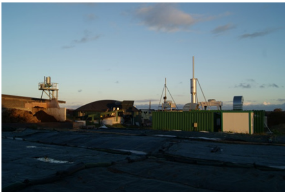
Abbildung 19: Bannsteinhof: Durch Separierung des Gärrests (Separator im Bild links) erhält der Landwirt zwei Düngemittel: Festen Gärrest und ein flüssiges Produkt mit sehr niedrigem Trockenmassegehalt, das sich auch zur Düngung in den wachsenden Bestand eignet. Foto: A. Ruf, Bannsteinhof.
