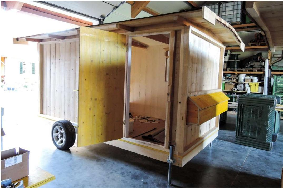
**Abbildung 8: Mobiler Kleingruppenstall System 2 im Bauzustand**
