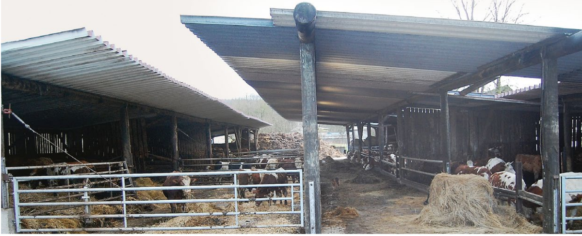
Der Tretmiststall für die Mastbullen wurde 2006 in einfacher Rundholzbauweise mit Pultdächern erstellt.
