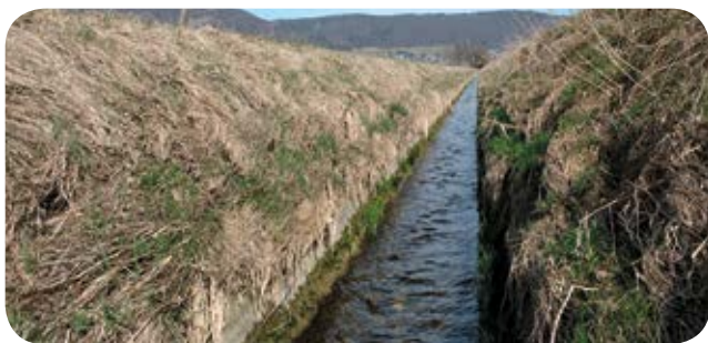
Vor der Aufwertung: Harte Verbauungen aus Beton sind für kleinere Wildtiere unpassierbar.
