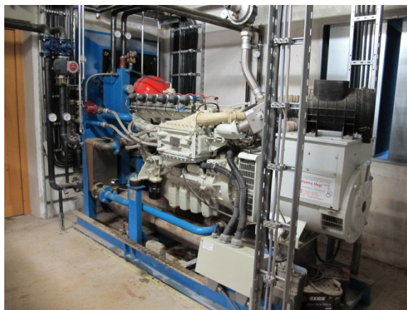
Фигура 29: КТЕ: биогаз за електричество и топлинна енергия. снимка: Ф. Йенш, RENAC.
