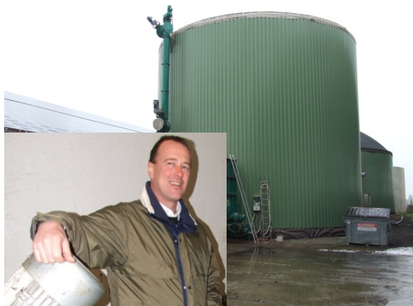
Фигура 17: Хуберт Милер, стопанин на биологични култури в Шмихен, Германия, работещ в сферата от 80-те години, управлява от шест години насам 333 киловатова инсталация за биогаз с извънредно висок ферментатор и вертикално бъркане. Той ползва смеска от субстрати с до 98 % детелина от около 20 стопанства. снимка: Ф. Герлах, МЕР.
