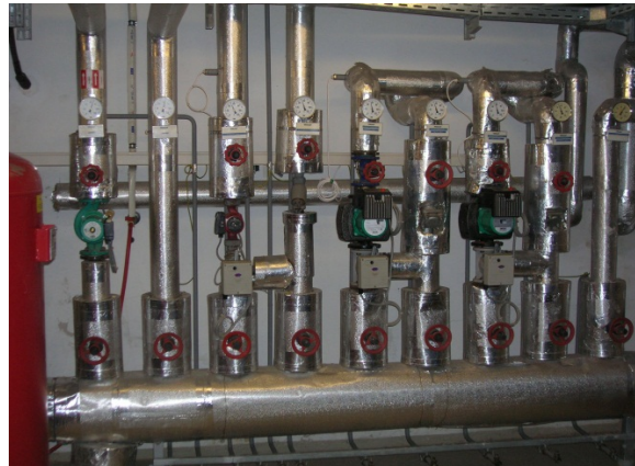
Фигура 23: Разпределение на топлината в биогаз инсталацията. Професионални концепции могат да спомогнат за оползотворяването на голяма част от произведената топлината. Снимка: MEP.
