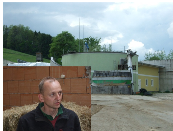
Фигура 8: Герхард Ублайс работи с инсталация за биогаз в Шваненштат/Горна Австрия, захранваща се с микс от биологична и конвенционална биомаса. Топлинната енергия се използва за сушене на дървени стърготини за гориво. Снимка: Ф. Герлах, FiBL.
