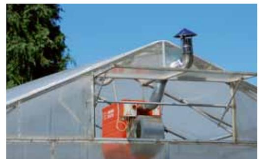
*Luftheizungen mit Direktfeuerung erlauben auch Solltemperaturen unter 0 °C und ermöglichen auf diese Weise bei robusten Pflanzen zusätzliche Energieeinsparungen.*
