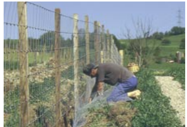
Eingraben eines Mäuseschutzgitters entlang des Zauns.
