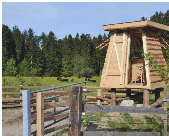
La cabine de tir de 180 × 180 cm se trouve à environ 1,5 m au-dessus du sol. La pièce mesure quelque 200 cm de haut, pour que le tireur puisse se tenir debout. La position de tir se situe à environ 3 m au-dessus du sol. Un tabouret de bar réglable en hauteur fait office de siège.
