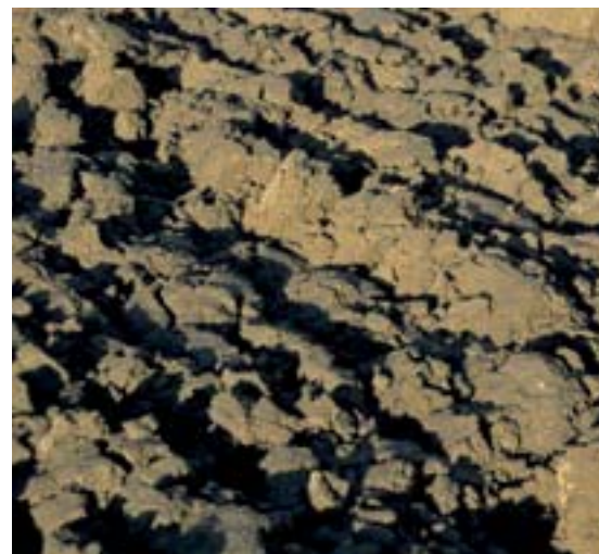
Durch einen Feldweg getrennt: Der selbe Boden unsachgemäss
